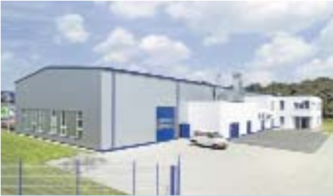
Das „Protective Coating Centre“ der Firma KSE Bautenschutz GmbH in Leipzig
