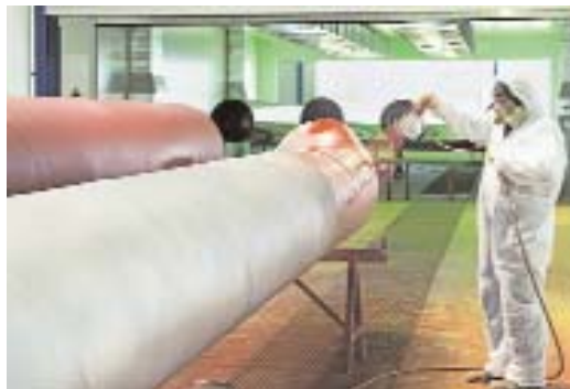
Grundierung von Kühlwasser-Leitungsrohren
